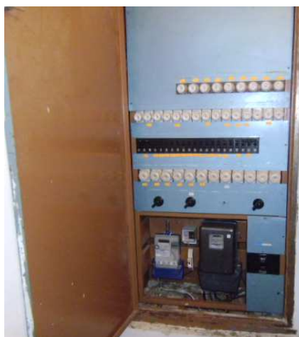
Obr. 6.: Rozvádzač NN s meraním spotreby
